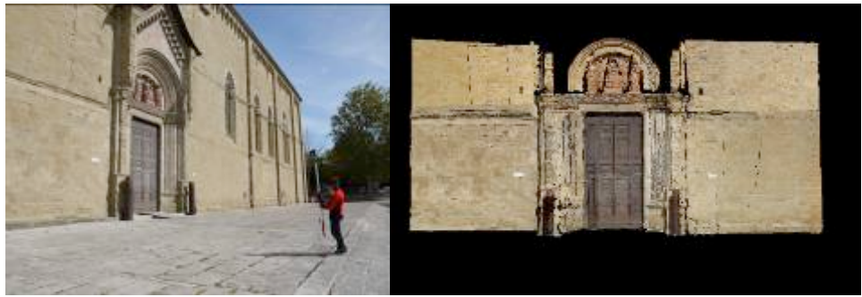
Fig. 22: Duomo di Arezzo. Da sinistra: distanza di presa per il rilievo e vista frontale della facciata ricostruita.
